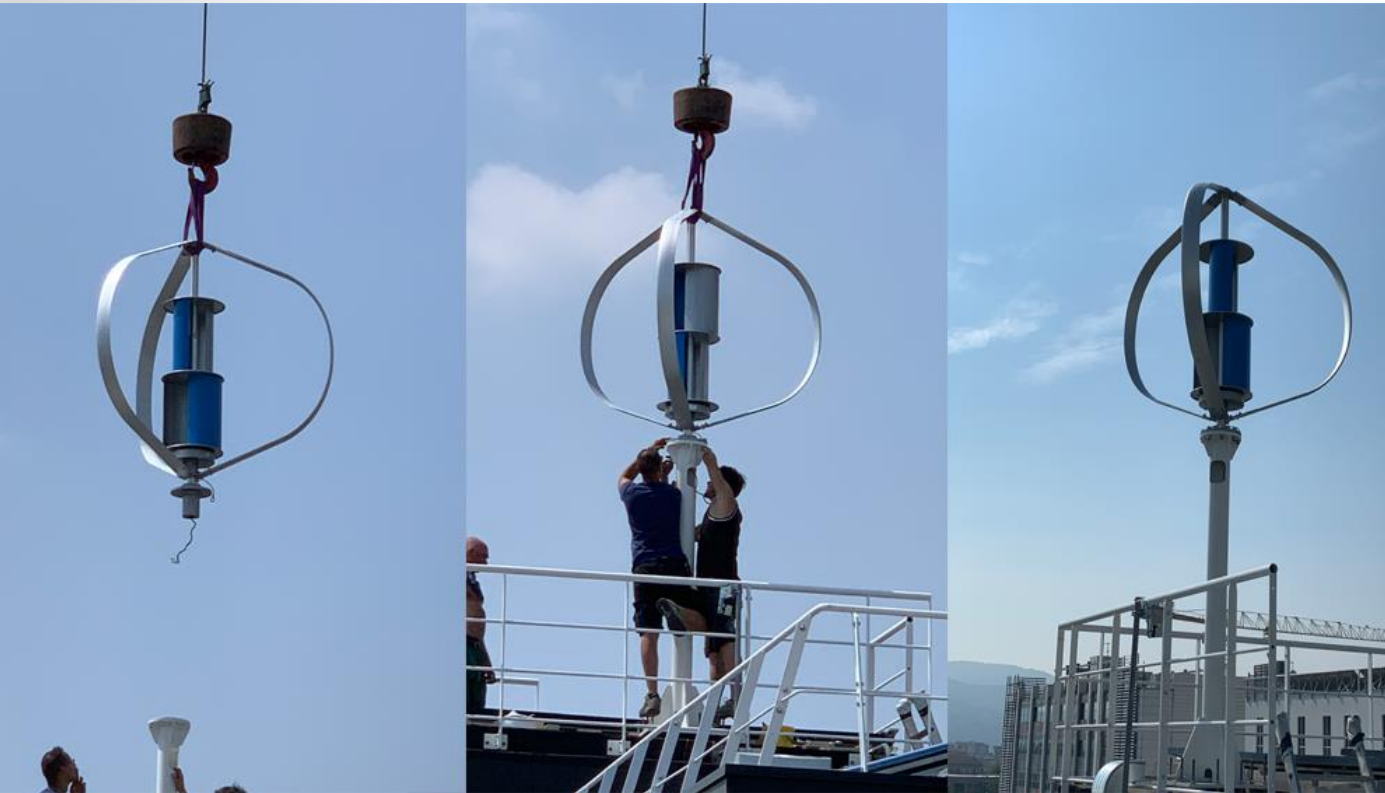
Tetto piano dell'Energy center del Politecnico di Torino
