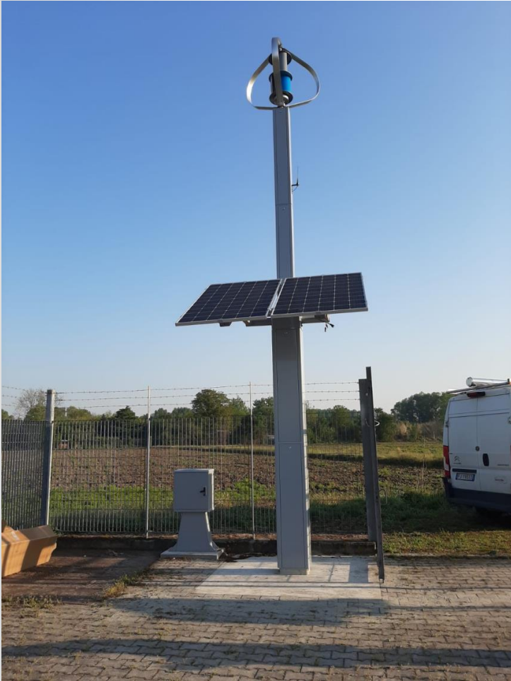
Palo ibrido eolico fotovoltaico presso sito Snam Rete Gas SPA a Gaggiano
