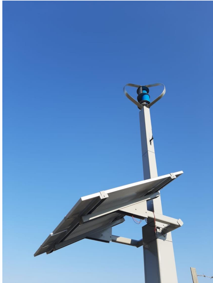
Palo ibrido eolico fotovoltaico presso sito Snam Rete Gas SPA a Gaggiano
