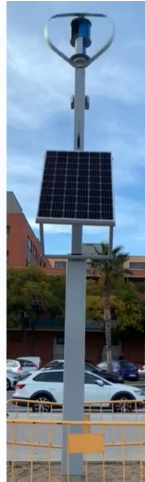
Lampione eolico/fotovoltaico installato a Viladecans Spagna
